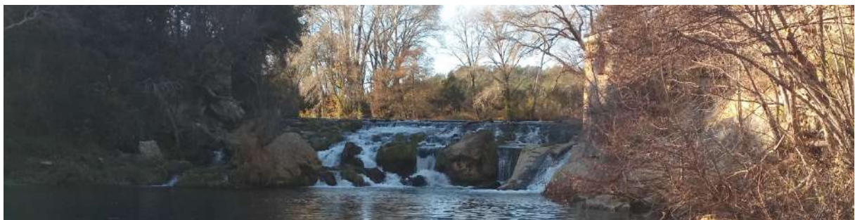
Figure 10 : Ouvrage de Sainte-Croix
