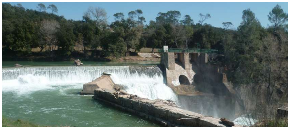
Figure 5 : Barrage d'Entraigues © Mairie de Canet des Maures
